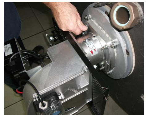
6) Зафиксировать горелки на котел;
