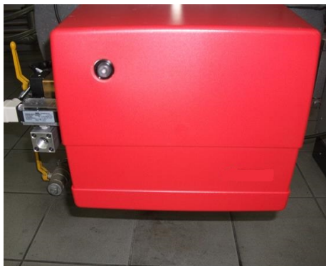
10) Переустановите кожух и Подключить газовую арматуру к газопроводу.
