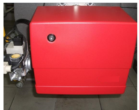
9) Переустановите кожух и Подключите газовую арматуру к газопроводу
