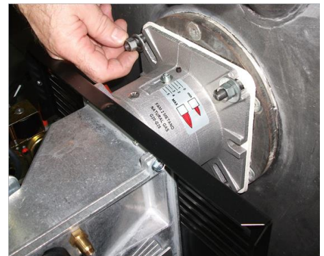
6) Зафиксировать горелки на котел;
